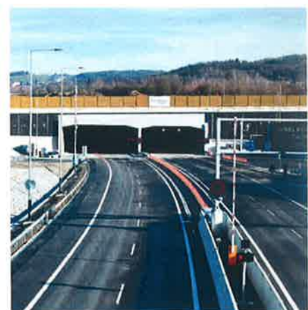
Dálnice D3 na obchvatu Českých Budějovic s tunelem Pohůrka (999 m) je připravena ke slavnostnímu otevření (21. 12. 24, ŘSD)
