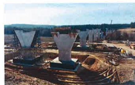
D3 stavba 0312/1 Kaplice-nádraží – Nažidla, betonáž pilířů estakády (10. 3. 25, Infram)
