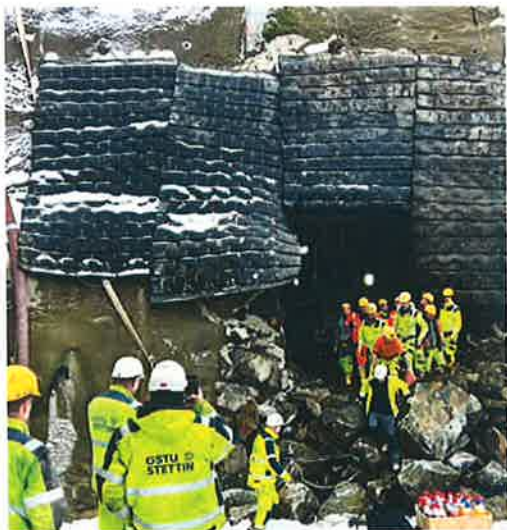
Rakouská S10 úsek Nord A prorážka tunelu Vierzehn (01/2025, ÖSTU Sttettin)
