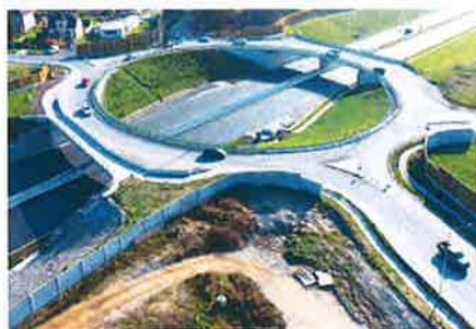
D3 0310/1 OK Hodějovice projektovaná pro připadné budoucí napojení sjezdů a využití jako MÚK, vozovky jsou připraveny pro vodorovné značení (podzim 24, ŘSD)
